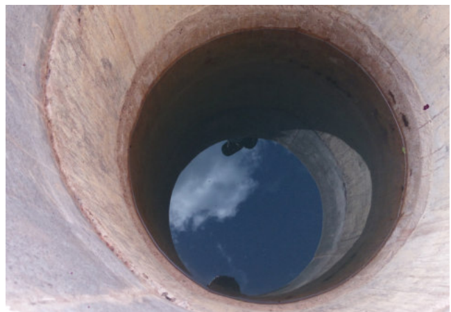
Licht am Ende des Tunnels? – Blick in den Brunnen in Missaouléna
