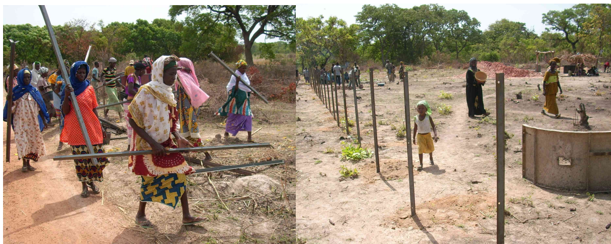
Grundsätzlich arbeiten Frauen und Männer im Projekt mit: z.B. beim Transport der Eisenstangen für die Einfriedung
